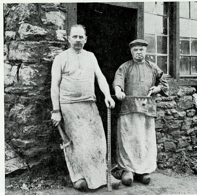
Planche 7. — Canonniers devant leur forge. Le premier, à gauche, s'appuie sur un canon ébauché; le second, à droite, tient un canon martelé et, à l'aide d'un outil appelé « hanchon », en vérifie le calibre extérieur.
